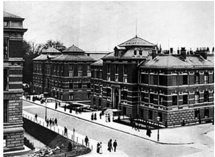
Gmach Elektrotechniki i Chemii w TH Darmstadt, koniec XIX wieku
