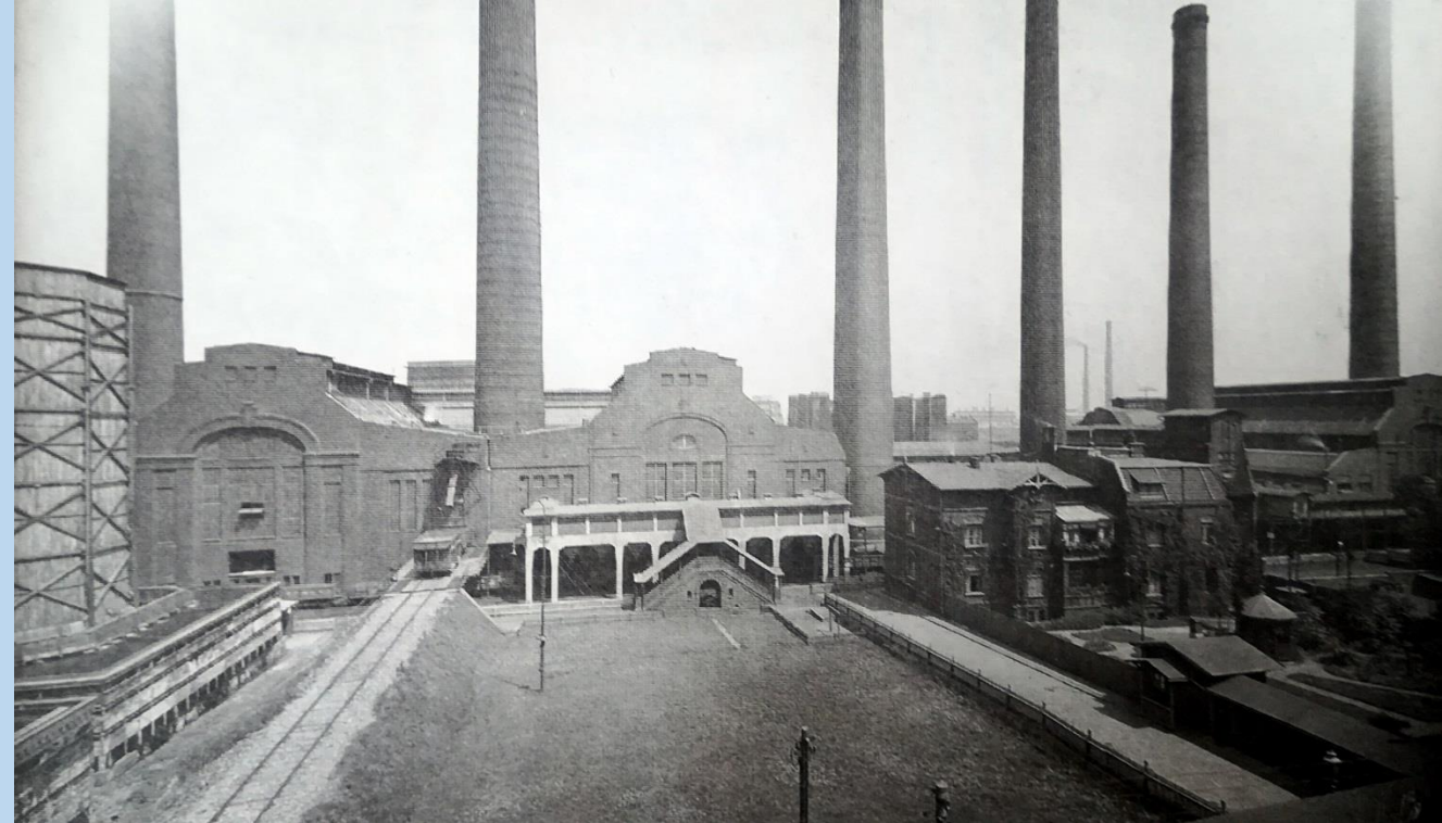
Elektrownia w Chorzowie w 1922 r., największa wówczas w Polsce The power station in Chorzów in 1922, the largest in Poland at the time
