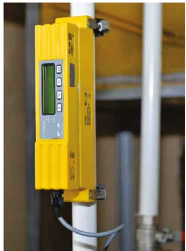
Rys. 2.10. Przepływomierz ultradźwiękowy zainstalowany na stanowisku laboratoryjnym
