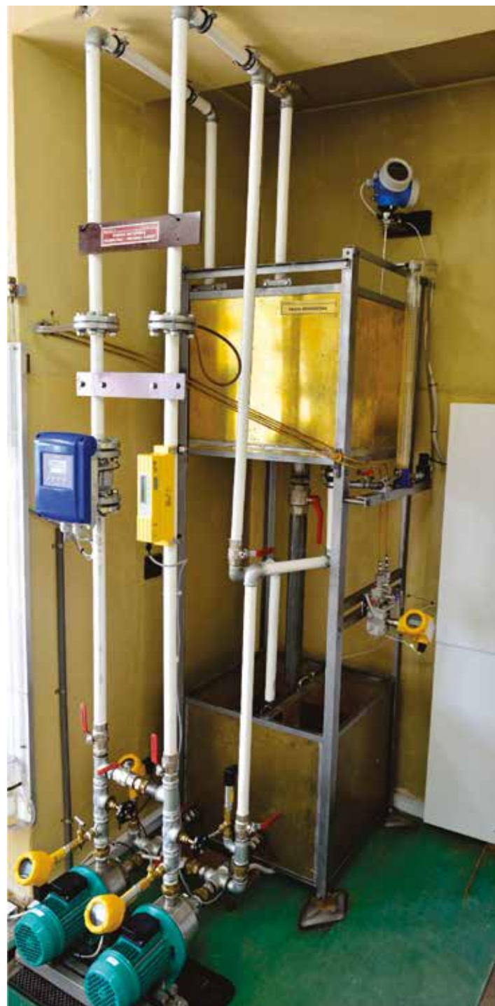
Rys. 2.3. Widok instalacji hydraulicznej w laboratorium
