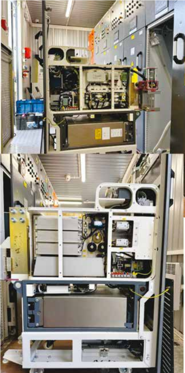
Rys. 4. Elementy składowe wyłącznika po zdjęciu obudowy
