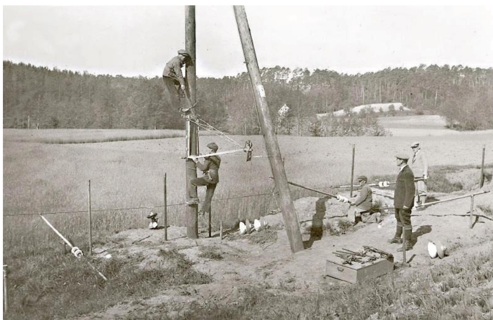
Praca przy budowie linii energetycznej średniego napięcia
