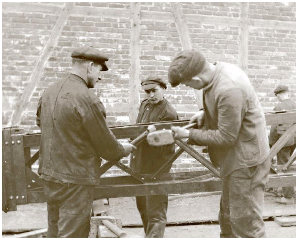
Pracownicy nitując słup energetycznej linii napowietrznej
