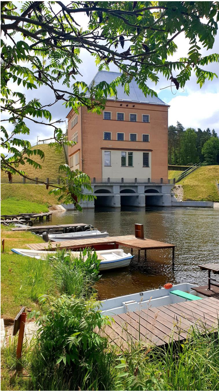
Elektrownia wodna Rosnowo
