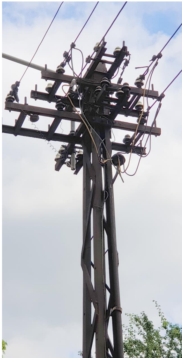
Wspaniały przykład krańcowego (obecnie) słupa linii nn. Lat około 100 i jeszcze w tak dobrym stanie. Lokalizacja - Krotoszyn (wielkopolska).
