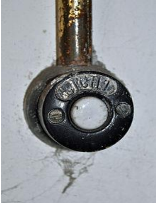
Przełącznik obrotowy j, obracany tylko zgodnie z ruchem wskazówek zegara
