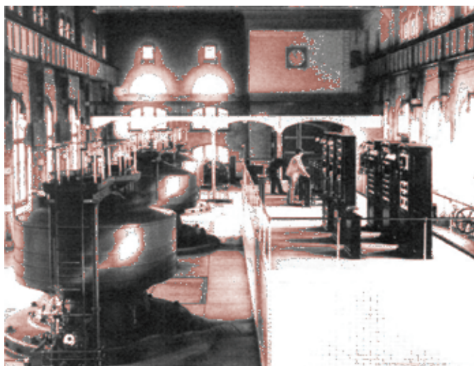
Rys. 8. Elektrownia na wodospadzie Niagara z trzema generatorami prądu zmiennego Tesli, 1896 r. [3]
