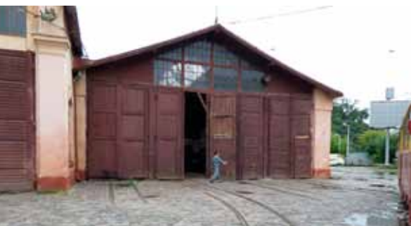
Foto 4.29 Zajezdnia tramwajowa stan obecny
